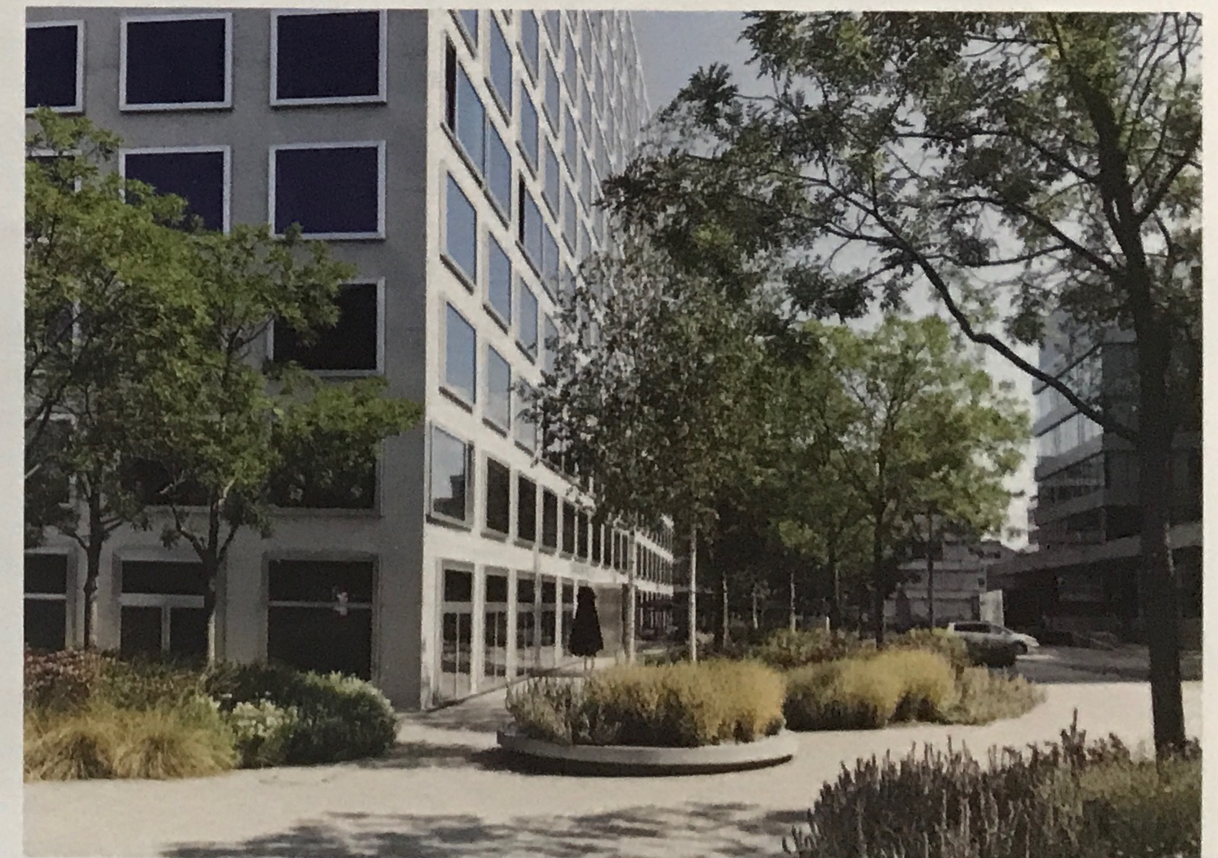
Diaconia Bethanien. Estat actual. Foto: Georg Aerni
