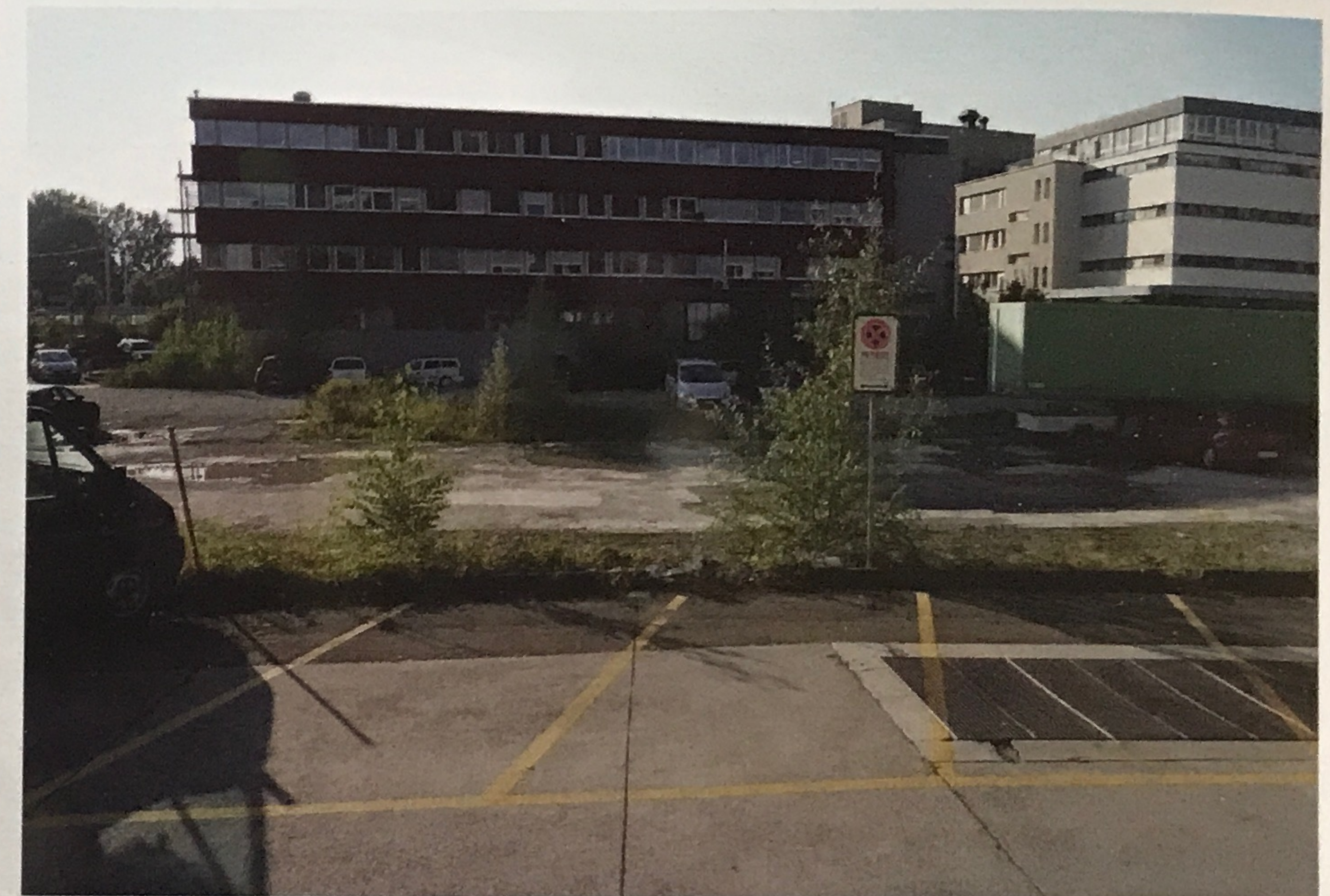
Àmbit del projecte per a la Diaconia Bethanien. Estat previ. Foto: María Viñé
